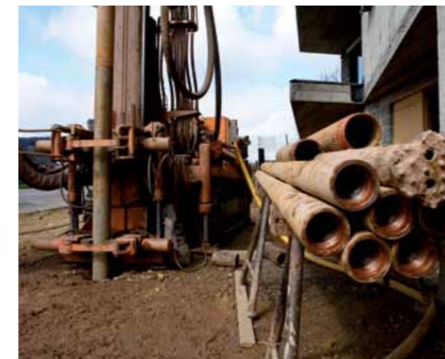
Erdsondenbohrung für Wärmepumpe
