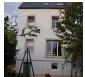
Nachher: Gartenseite mit Außendämmung
