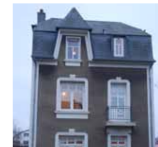
Vorher: Straßenseite ungedämmt
